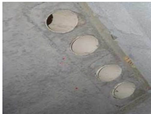
Figura: luvas concretadas em laje do pavimento
