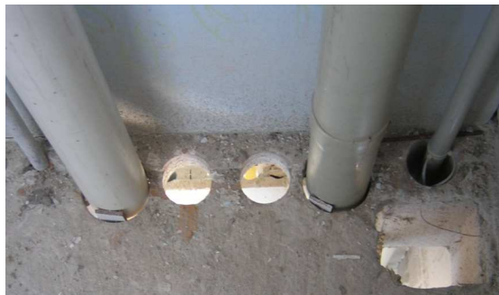
Figura: Prumadas instaladas aguardando fixação
