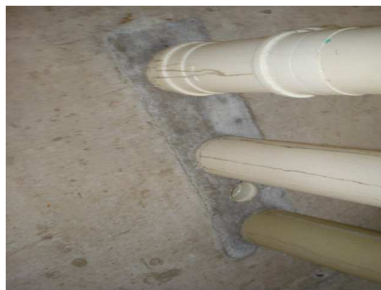
Figura: prumadas executadas
