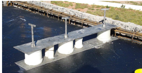
Figura: Previsão de gabarito com luvas . Antes da concretagem.
