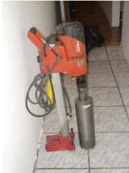
Figura: Abertura de furo para prumadas
